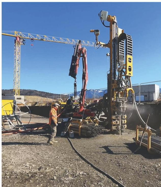
Des forages ont été réalisés pour installer une cinquantaine de sondes géothermiques plongeant à 200 m de profondeur.
